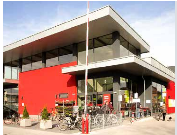
Lünen, Alstedder Straße 138-140
