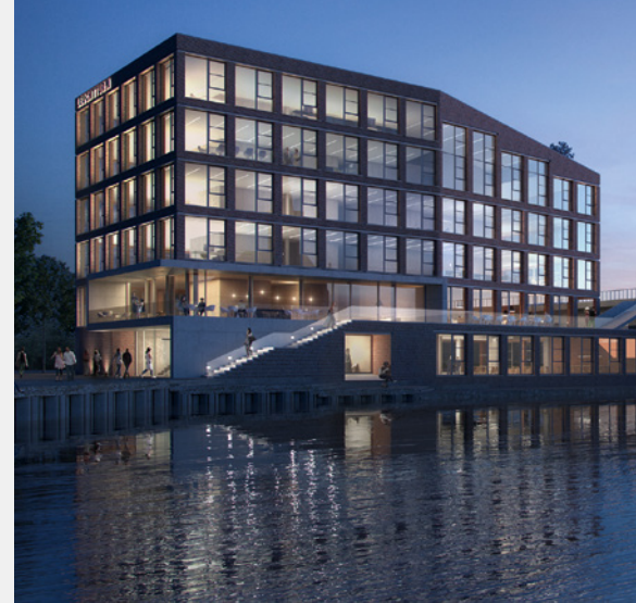
Der „Leuchtturm“ wird das Herzstück des neuen Hafenquartiers und Adresse für zahlreiche Startups
