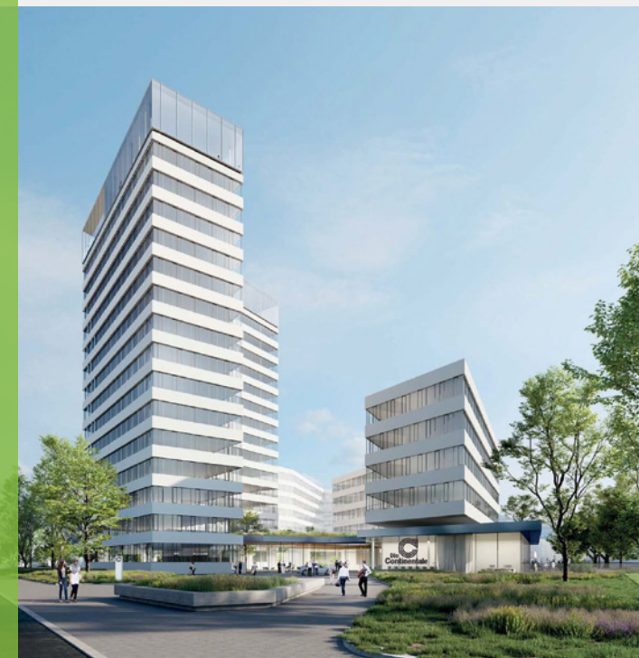
Die neue Continentale-Zentrale ist ein Ensemble aus drei Baukörpern von unterschiedlicher Höhe
